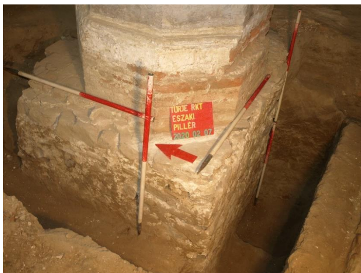
Az északi pillér alapozása
